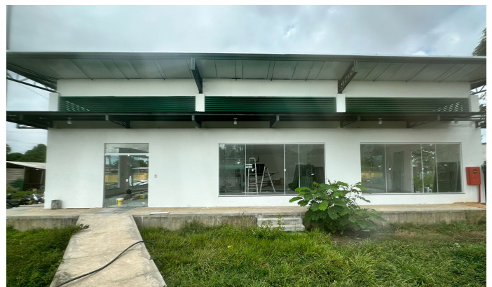
Construção do Refeitório
