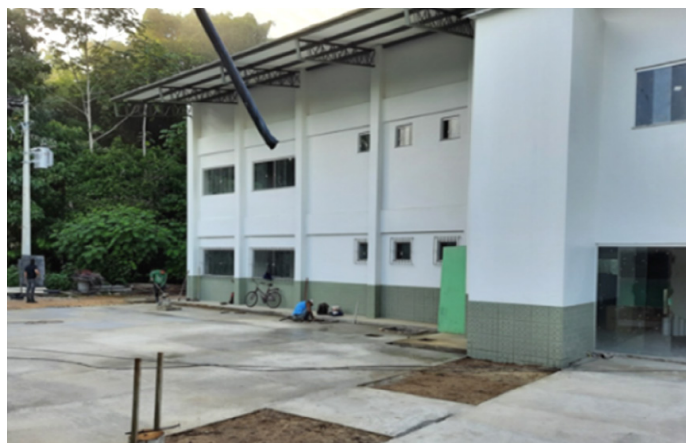
Construção do bloco pedagógico e de pesquisa
