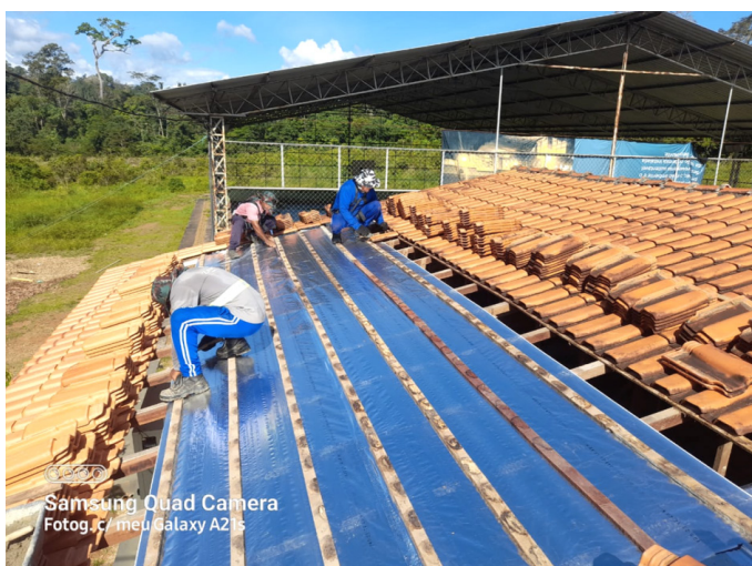
Reforma do telhado
