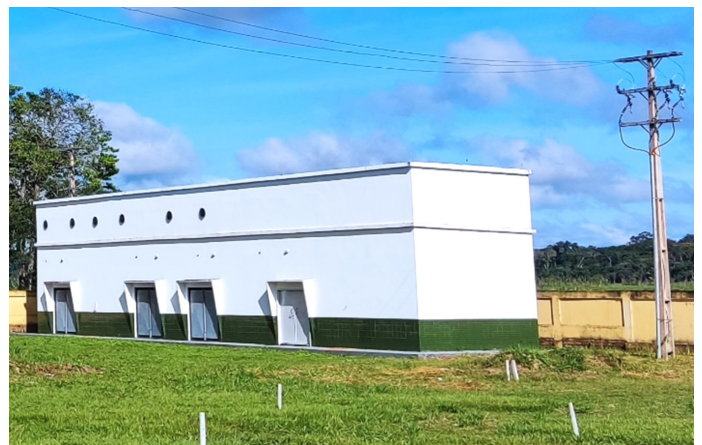
Subestação e rede elétrica
