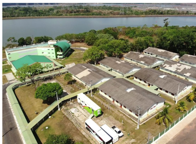
Reforma dos antigos alojamentos
