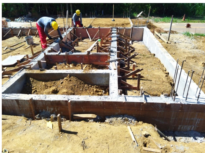
Construção do Bloco Pedagógico
