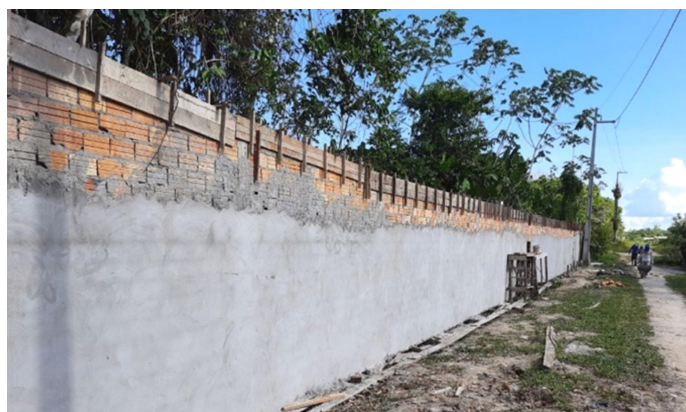
Construção do muro
