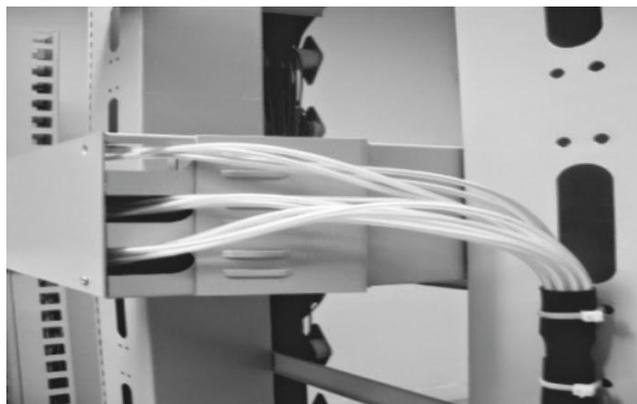
A fixação do cabo no RACK, não pode tirar a flexibilidade dos tubos transparentes.
